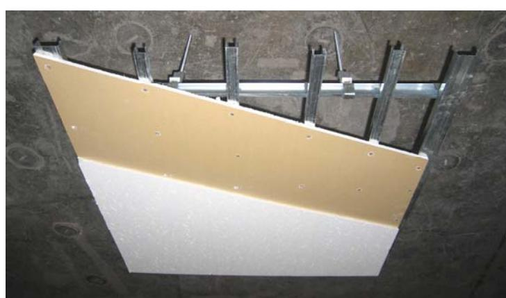
写真 3.1.1 : 天井面の構成 (ロックウール吸音板石膏ボード捨張り)
