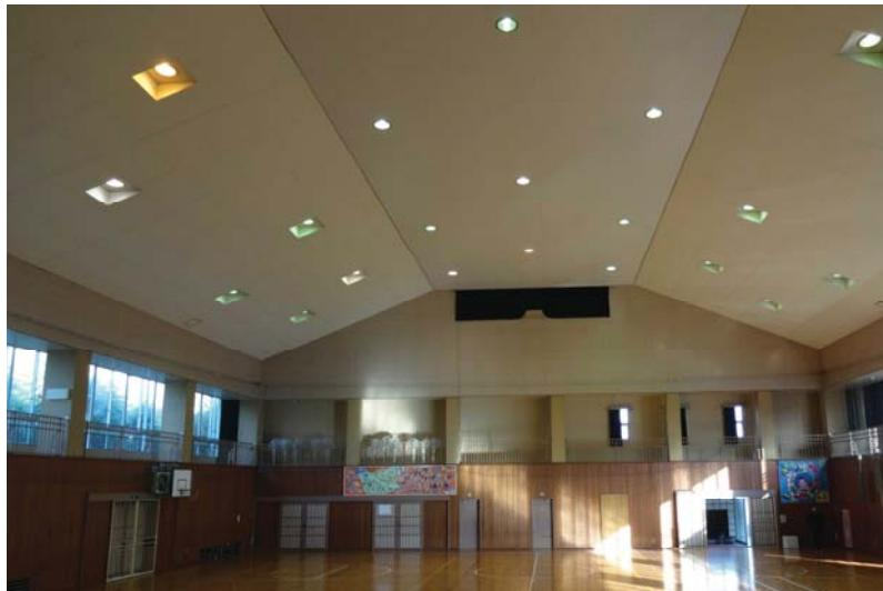
写真 3.2.1：折れ曲がりを持つ天井（平天井つき舟底天井）の例
