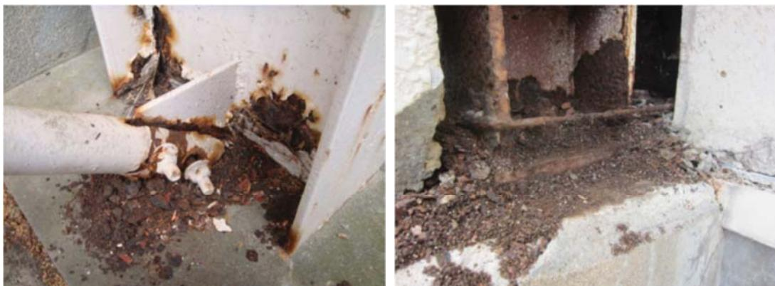
写真 3.1.8: 鉄骨部材の著しい腐食の例
