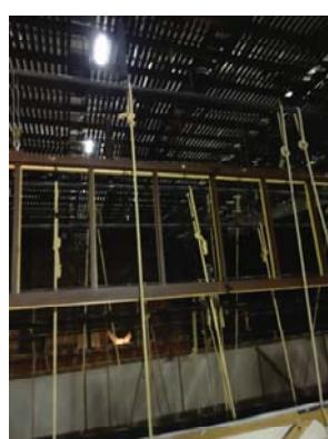
図付 1.3.2 : 空調設備の落下防止対策の例
