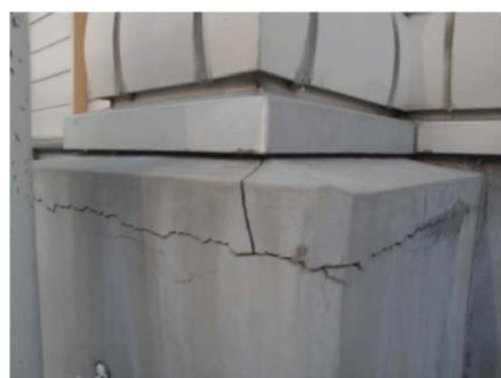
写真 3.1.5 : 破損した柱脚の例
