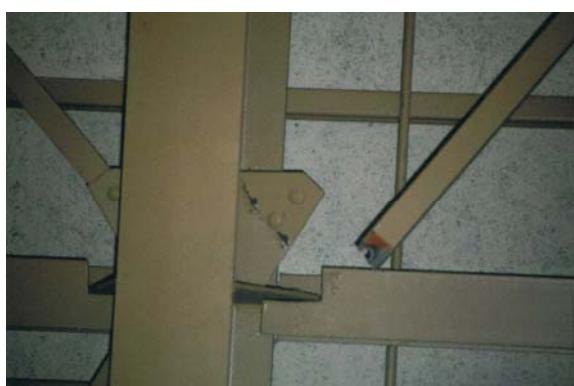
写真付 2.1.3 : 耐力の不十分な接合部の破断
