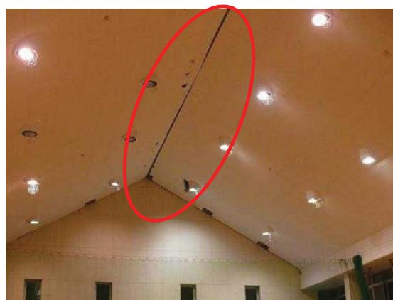
写真 3.2.3：吊り天井の部分的なずれの例<sup>21)</sup>
