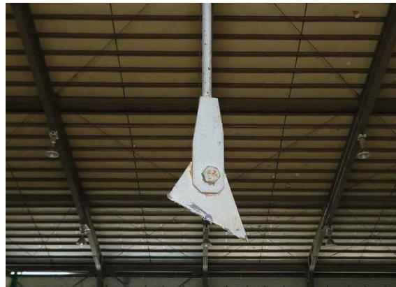
写真付 2.1.5：ターンバックルプレースの接合部破断
