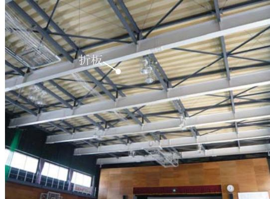
写真 1.2.6 : 吊り天井なしの例 (折板葺き屋根の裏面が露出)
