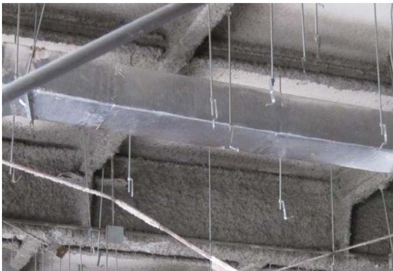
写真 3.8.2：ハンガーの損傷の例<sup>15)</sup>
