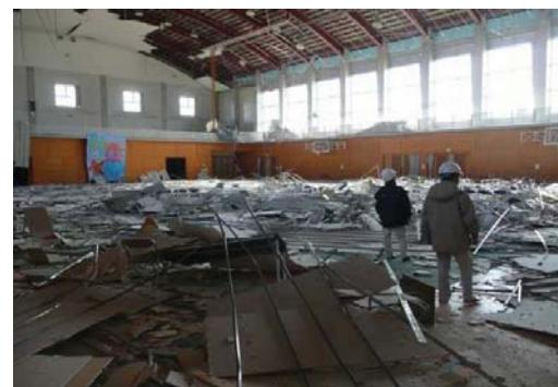
写真 1.4 : 在来工法による天井の地震被害 <sup>4)</sup>
