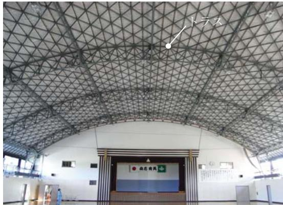
写真 1.2.5 : 吊り天井なしの例 (トラスが露出)
