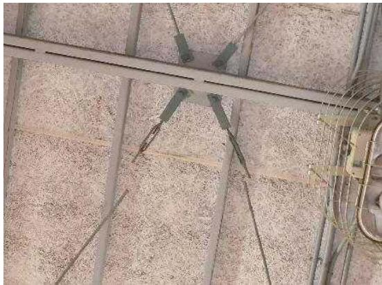
写真付 2.1.4：伸び能力のないターンバックルプレースの破断
