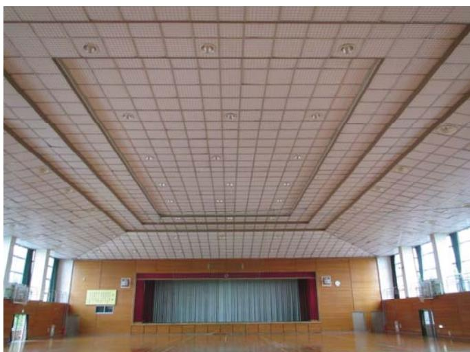
写真 3.2.2：段差天井（複数の天井立上りを持つ天井）の例<sup>9)</sup>
