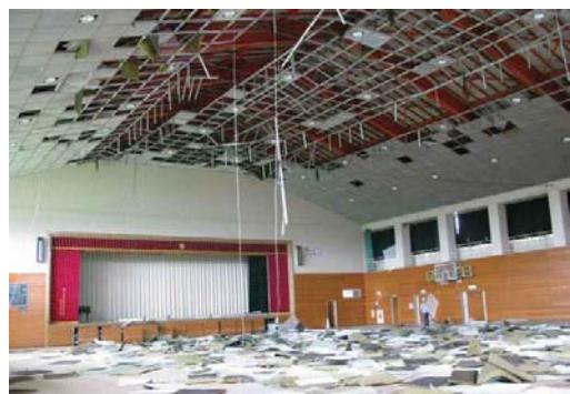
写真 1.3 : システム天井の地震被害 <sup>3)</sup>
