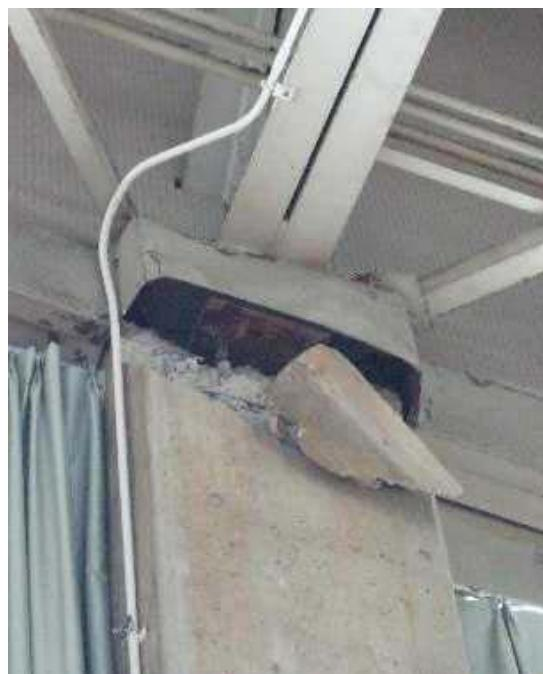
写真付 2.1.2 : 定着部コンクリートの破壊
