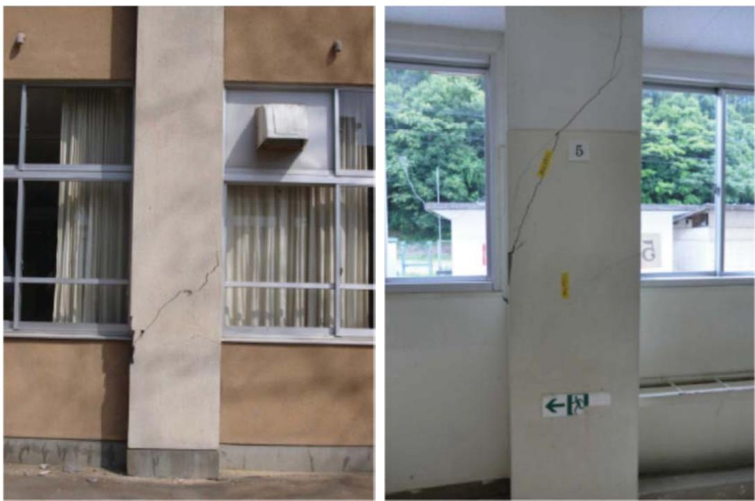
写真 3.1.7: 比較的大きなコンクリートのひび割れの例
