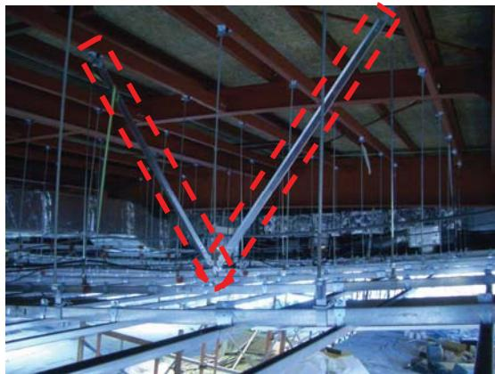
写真 1.3.2：斜め部材（プレース）の例
