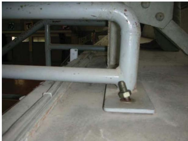
写真付 1.2.3 : 取付け部の緩みの例<sup>17)</sup>
