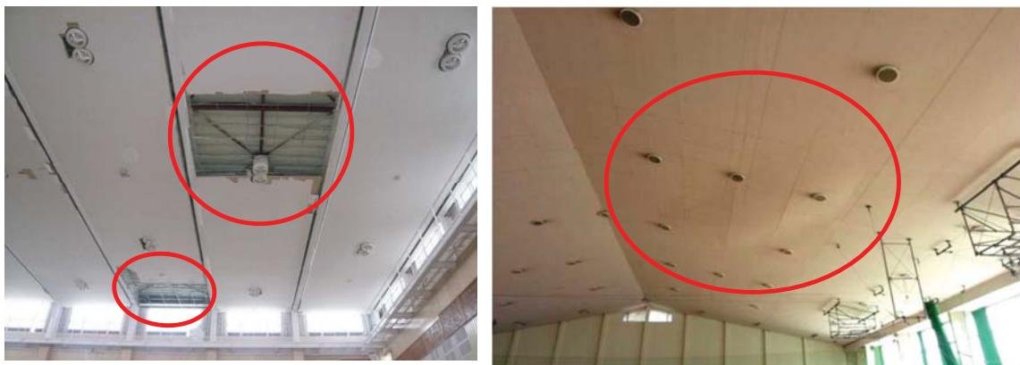
写真 3.2.1：吊り天井の落下又は落下しかけている被害の例<sup>19)</sup>
