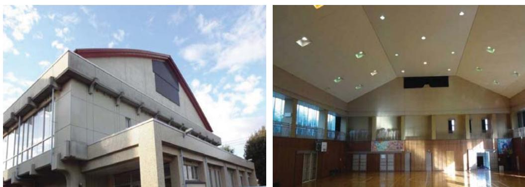
写真1.4.1：屋根形状（外観）と天井形状（内観）の比較例
