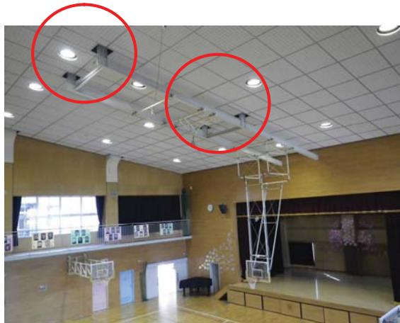
写真 3.7.1: 吊下式バスケットゴールの支柱と天井の取り合い部<sup>13)</sup>
