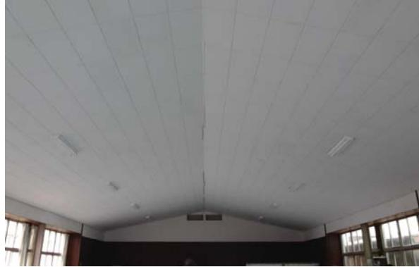
写真 1.2.4 : 吊り天井ありの例 (舟底天井)
