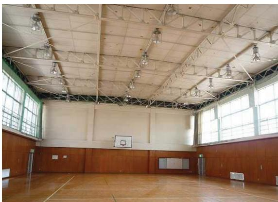
写真付 2.1.1: RC 造の柱梁の上に鉄骨小屋組が乗っている体育館
