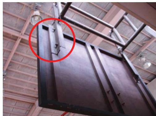
写真付 1.2.6 : バックボードの取付け部の例
