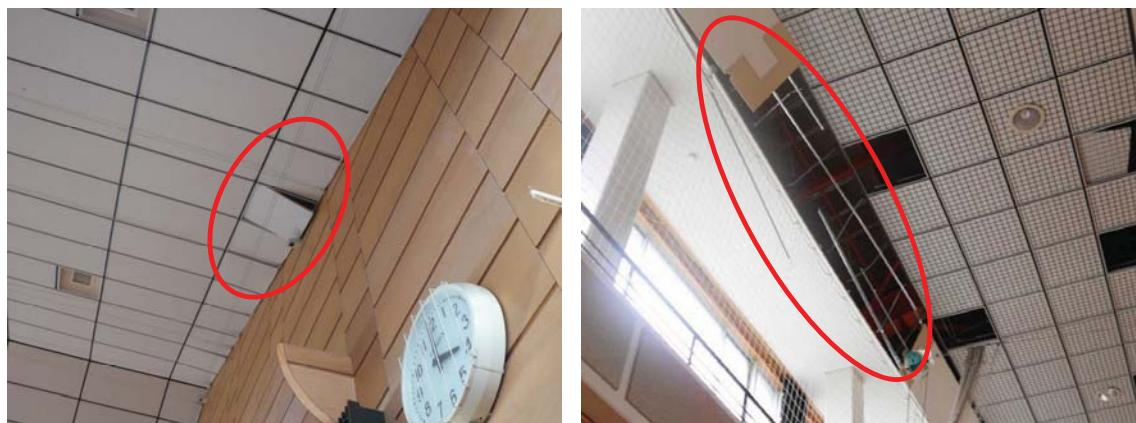
写真 3.2.2：天井の周囲・段差の破損の例<sup>20)</sup>
