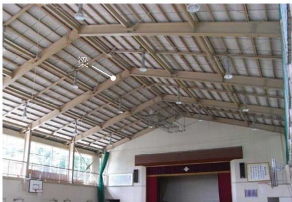
写真1.2.1：吊り天井なしの例（梁が露出）
