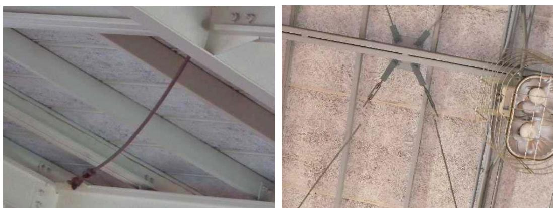
写真 3.1.11: たわんだ天井プレース・破断した天井プレースの例
