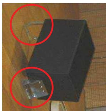
写真付 1.3.1 : 放送設備の取付部分・舞台装置の落下防止対策の例
