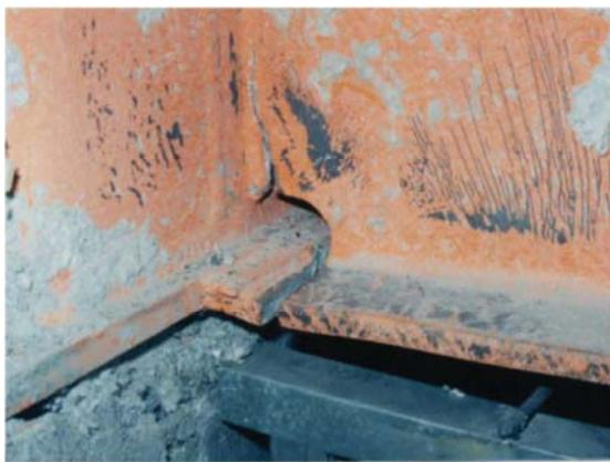
写真 3.1.4: 接合部での破断の例
