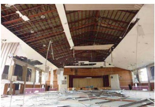
写真 1.5 : 在来工法による天井の地震被害 <sup>5)</sup>
