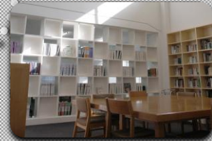
室用途に配慮し、棚兼用の格子鋼板耐震壁による補強(建築学棟図書館閲覧室)
