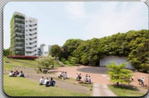
周辺環境と調和するよう壁面を緑化し、生きた教材としても活用(建築学棟)
