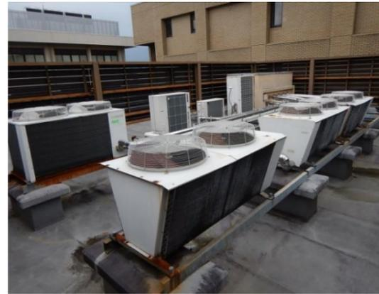
写真1 老朽化した空調設備（写真は室外機）
