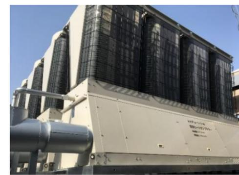
図5 機器更新後の空冷ヒートポンプチラー
