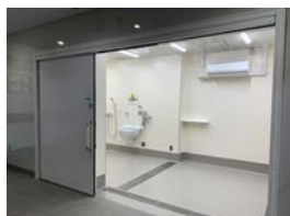
■A棟除染室改修(除染室)
