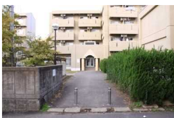
④. 留学生会館A棟・B棟(1988)
