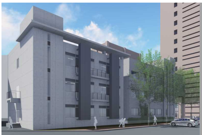
⑪. 産学融合拠点施設(仮称) (2024新営) 2024年に経済産業省「地域の中核大学等インキュベーション・産学融合拠点の整備(Jイノブラ2)」の補助金等により産学融合拠点の整備を予定。
