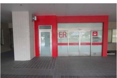
㉓. A棟救急部除染室(2020) 福井県原子力災害拠点施設整備の補助事業によりA棟救急部除染室の増築整備を行った。
