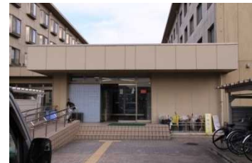
③. 国際交流学生宿舎C棟 (1966、2002耐震改修) 平成14年に耐震・機能改修完了
