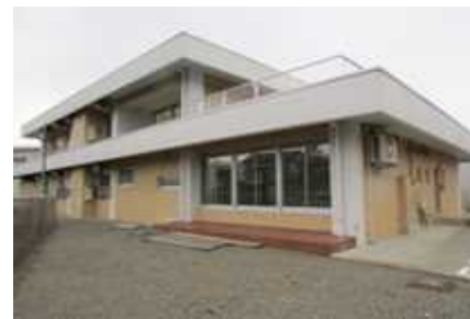
⑨. 牧島ハウス(留学生宿舎)(1983、2018改修) 2018年に「県内大学等留学生宿舎整備事業補助金」等により留学生宿舎への改修を行った。
