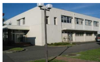
⑧. 福利施設(1983) 築41年を経過し、老朽化が進んでいる。
