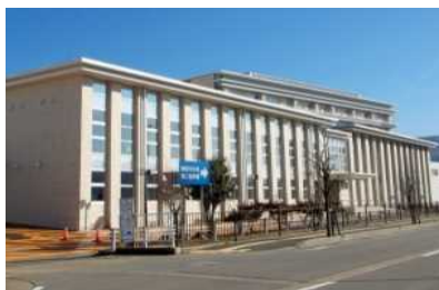
⑮. 福井メディカルシミュレーションセンター(2013) 県内全ての医療従事者を対象に多様な実技トレーニングのできる研修施設を整備し、県内医療従事者の技術向上を図る。県の基金にて整備を行った。
