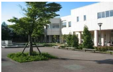
①. 基礎実習棟(1980) 松岡キャンパスで最初に建てられた建物。耐震性に問題はないが、築44年を経過し、老朽化が進む。(2024年整備計画予定)
