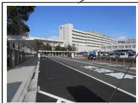
■附属病院正面付近 附属病院正面付近では、屋根付き歩道を含む外来駐車場改修を行った。
