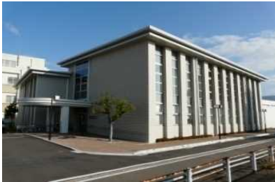
⑭. 臨床教育研究センター(2009) 平成21年に寄付金にて整備を行った。
