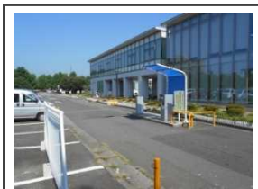
■第1駐車場前のゲート 病院側の道路を渡ると屋根付きの歩道がある。
