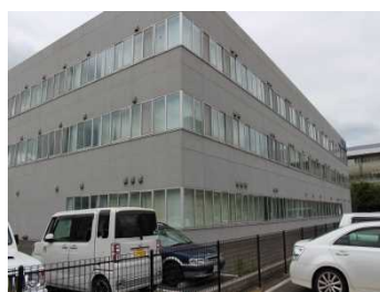
⑤. 東面外観
