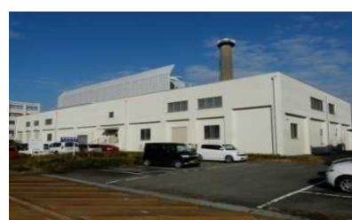
⑤. 中央機械室(エネルギーセンター)(1981) 築43年を経過し、老朽化が進んでいる。病院、校舎等ほとんどすべての熱源、電源、水道の供給をしている。ボイラー、冷凍機、中央監視、自家発電設備等を一部改修済。 また、2014年度に管理一体型ESCO事業に関連し、熱源設備・システムの大型改修を行った。
