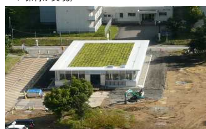
⑲. RI排水処理施設(2011) 病棟建設に先駆け2011年に自己資金による整備を行った。
