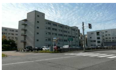
⑩. 院生研究棟(1985) 築39年を経過し、老朽化・機能劣化が進んでいる。
