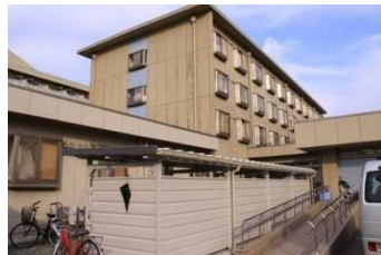
②. 国際交流学生宿舎B棟 (1965.1966、2002耐震改修) 平成14年に耐震・機能改修完了。
