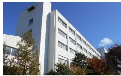
⑦. 基礎研究棟(1981) 築45年を経過し、老朽化が進んでいる。2009年に耐震改修及び部分改修を行った。
