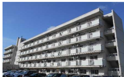
⑬. 看護師宿舎B棟(1984, 1996) 築42、30年を経過し、老朽化が進んでいる。看護師職員宿舎。
