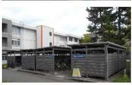
■ 総合研究棟Ⅲ周辺状況
