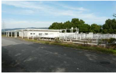
③. 排水処理機械室(1980) 築46年を経過し、老朽化が進む。
