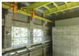
■大型構造物実験室(上部)
