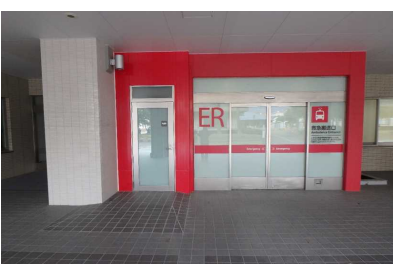
㉕. A棟救急部除染室(2020) 福井県原子力災害拠点施設整備の補助事業によりA棟救急部除染室の増築整備を行った。
