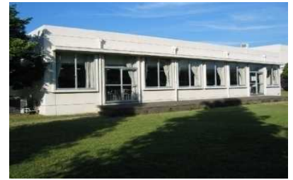
②. 食堂(1980) 築46年を経過し、老朽化が進んでいたため、平成22年度に一部内部のリフレッシュ改修を行った。また平成27年度に厨房の改修を行った。
