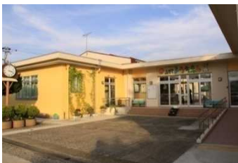
①. 附属幼稚園(1967、1974、2010) 2010年度に耐震改修及び遊戯室の増築を完了した。
