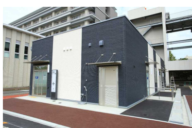
㉖. 多用途型トリアージ施設(2021) 自然災害や大規模事故等の際の多用途型トリアージ施設の整備を一部自己資金により行った。
