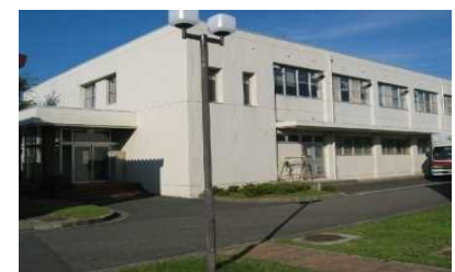
⑧. 福利施設(1983) 築43年を経過し、老朽化が進んでいる。
