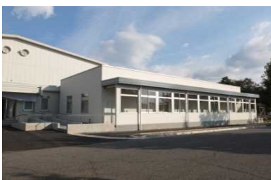
㉒. スチューデント・アクティビティプラザ(2012) 2012年に仮設講義室として使用後、スポーツ施設として使用するために自己資金による整備を行った。
