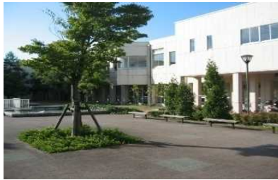
①. 基礎実習棟(1980) 松岡キャンパスで最初に建てられた建物。耐震性に問題はないが、築46年を経過し、老朽化が進む。(2024年整備計画予定)
