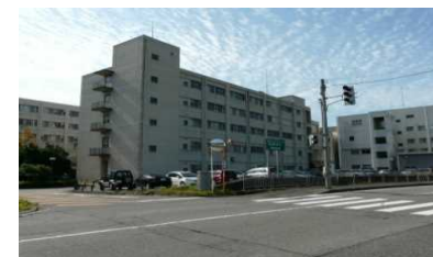
⑩. 院生研究棟(1985) 築41年を経過し、老朽化・機能劣化が進んでいる。
