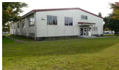
⑨. 武道場(1984) 築42年を経過し、老朽化が進んでいる。2011年に便所等のアメニティスペースの改修を行った。
