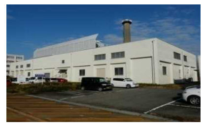
⑤. 中央機械室(エネルギーセンター)(1981) 築45年を経過し、老朽化が進んでいる。病院、校舎等の熱源、電源、水道の供給。ボイラー、冷凍機、中央監視、自家発電設備等を一部改修済。2014年度管理一体型ESCO事業により熱源設備・システムの大型改修を行った。
