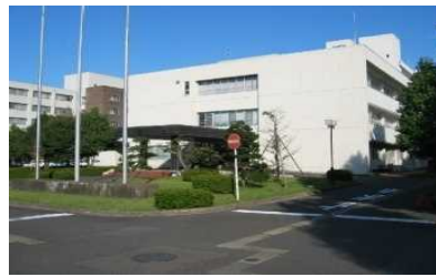
④. 管理棟(1981) 耐震性は確保されているが、築45年を経過し、老朽化が進んでいる。また、バリアフリー対応になっていない。
