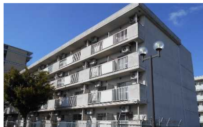
⑫. 看護師宿舎A棟(1983) 築43年を経過し、老朽化が進んでいる。看護師職員宿舎。
