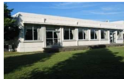
②. 食堂(1980) 築45年を経過し、老朽化が進んでいたため、平成22年度に一部内部のリフレッシュ改修を行った。また平成27年度に厨房の改修を行った。
