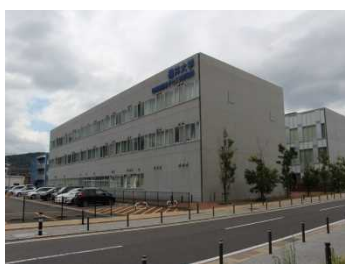
④. 北西面外観
