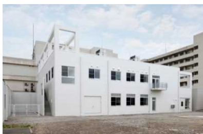
⑱. 附属病院MRI棟(2011) 新病棟建設に先駆け2011年に自己資金による整備を行った。
