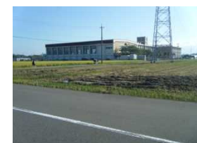
敷地東側(藤島中学校)
