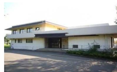
⑪. くずりゅう会館(1986) 築39年を経過し、老朽化が進んでいる。 非常勤講師宿泊施設、職員福利施設。
