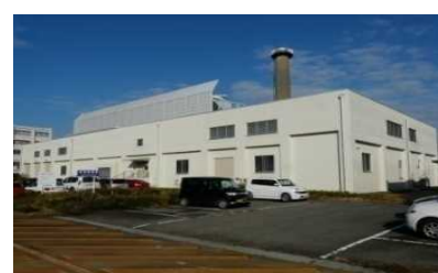
⑤. 中央機械室(エネルギーセンター)(1981) 築44年を経過し、老朽化が進んでいる。病院、校舎等ほとんどすべての熱源、電源、水道の供給をしている。ボイラー、冷凍機、中央監視、自家発電設備等を一部改修済。 また、2014年度に管理一体型ESCO事業に関連し、熱源設備・システムの大型改修を行った。
