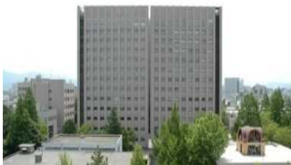
⑦. 総合研究棟 I (2002、2008) 2008年に本学最初の総合研究棟として建築。東棟を増築し、一部自己資金により整備した。
