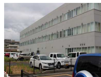
⑥. 南東面外観
