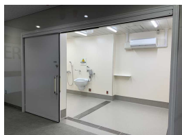
■A棟除染室改修(除染室)
