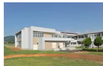
⑥. 校庭から増築された屋内運動場(兼体験学習等施設)の建物(2014)を望む
