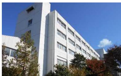
⑦. 基礎研究棟(1981) 築44年を経過し、老朽化が進んでいる。 2009年に耐震改修及び部分改修を行った。
