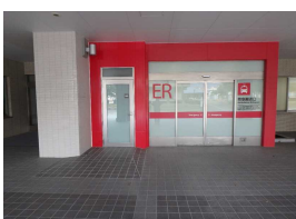
■A棟除染室改修(外観)
