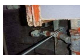
腐食・発錆が著しい配管類
