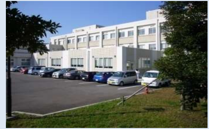
⑬. 附属病院リハビリ棟(2005) 既存施設が狭隘であるため2005年に自己資金にて増築整備を行った。
