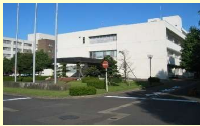
④. 管理棟(1981) 耐震性は確保されているが、築41年を経過し、老朽化が進んでいる。また、バリアフリー対応になっていない。
