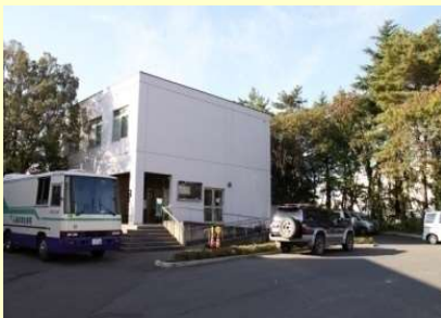
③. 保健管理センター(1975) 築47年を経過し、老朽化が進んでいる。
