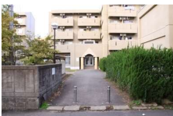
④. 留学生会館A棟・B棟(1988)
