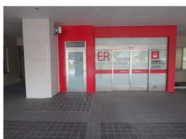
■A棟除染室改修 (外観)
