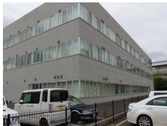
⑤. 東面外観
