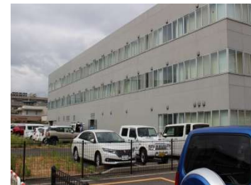
⑥. 南東面外観
