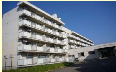
⑦. 看護師宿舎(1983, 1996) 築39年を経過し、老朽化が進んでいる。1996年に部分改修を行った。
