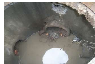
雨水配管が破壊しており、木根が侵入し、流れを阻害していた部分
