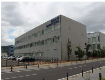
④. 北西面外観
