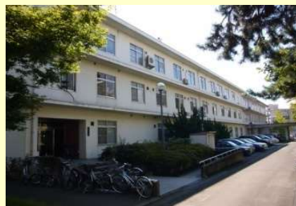
④. 総合研究棟Ⅶ-2(工学系4号館(東)) (1985) 耐震性は確保されているが、築37年で老朽化・機能劣化が進んでおり、工学系建物の中で唯一未改修である。
