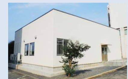
㉒. コンベンショナル動物施設(2014) 本学の強みである脳科学領域の研究・教育基盤の全学的な強化・促進を目的として自己資金により検疫を必要としないコンベンショナル(CV)動物飼育室の整備を行った。
