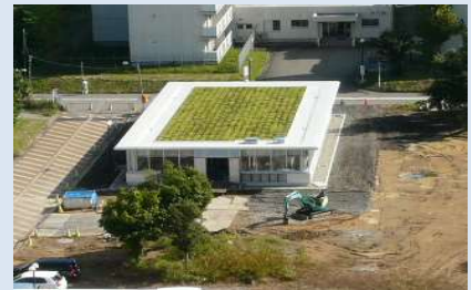
⑲. RI排水処理施設(2011) 病棟建設に先駆け2011年に自己資金による整備を行った。
