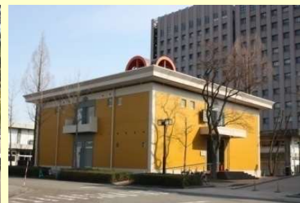
⑤. 総合情報基盤センター(1986) 築36年を経過し、老朽化が進んでいる。2011年に外壁・防水改修完了。
