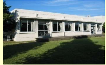
②. 食堂(1980) 築42年を経過し、老朽化が進んでいたため、平成22年度に一部内部のリフレッシュ改修を行った。また平成27年度に厨房の改修を行った。
