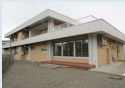
⑨. 牧島ハウス(留学生宿舎) (1983, 2018改修) 2018年に「県内大学等留学生宿舎整備事業補助金」等により留学生宿舎への改修を行った。
