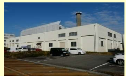
⑤. 中央機械室(エネルギーセンター)(1981) 築41年を経過し、老朽化が進んでいる。病院、校舎等ほとんどすべての熱源、電源、水道の供給をしている。ボイラー、冷凍機、中央監視、自家発電設備等を一部改修済。 また、2014年度に管理一体型ESCO事業に関連し、熱源設備・システムの大型改修を行った。
