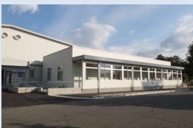
⑳. スチューデント・アクティビティプラザ(2012) 2012年に仮設講義室として使用後、スポーツ施設として使用するために自己資金による整備を行った。
