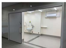
■A棟除染室改修 (除染室)
