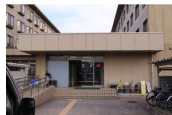
③. 国際交流学生宿舎C棟 (1966, 2002耐震改修) 平成14年に耐震・機能改修完了
