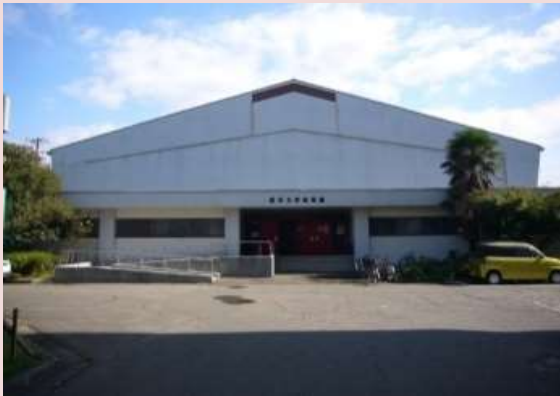
①. 第1体育館(1965) 築57年を経過し老朽化が著しい。また、随時部分改修を行っているが、天井高が低く、公式試合が出来ない等、活動に支障をきたしている。
