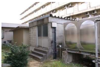
⑤. ポンプ室(1975.2000)
