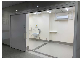
■A棟除染室改修 (除染室)
