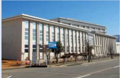
⑮. 福井メディカルシミュレーションセンター(2013) 県内全ての医療従事者を対象に多様な実技トレーニングのできる研修施設を整備し、県内医療従事者の技術向上を図る。県の基金にて整備を行った。
