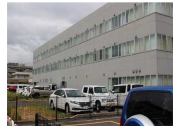
⑥. 南東面外観
