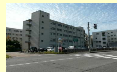
⑩. 院生研究棟(1985) 築37年を経過し、老朽化・機能劣化が進んでいる。
