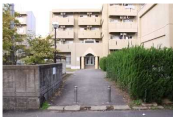
④. 留学生会館A棟・B棟(1988)
