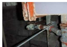
腐食・発錆が著しい配管類
