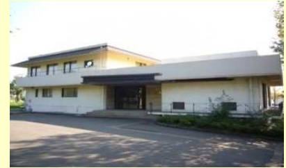
⑪. くずりゅう会館(1986) 築36年を経過し、老朽化が進んでいる。非常勤講師宿泊施設、職員福利施設。
