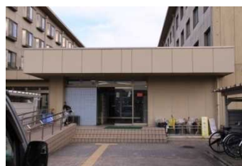
③. 国際交流学生宿舎C棟 (1966, 2002耐震改修) 平成14年に耐震・機能改修完了
