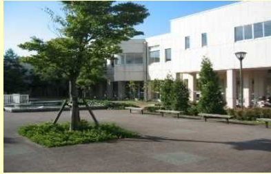
①. 基礎実習棟(1980) 松岡キャンパスで最初に建てられた建物。耐震性に問題はないが、築42年を経過し、老朽化が進む。
