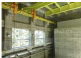
■大型構造物実験室(上部)
