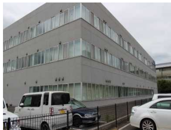
⑤. 東面外観
