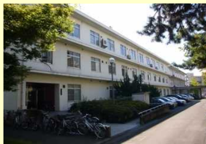
④. 総合研究棟Ⅶ-2(工学系4号館(東)) (1985)
