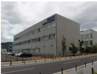
④. 北西面外観
