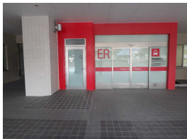
■A棟除染室改修 (外観)
