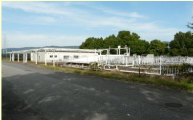
③. 排水処理機械室(1980) 築41年を経過し、老朽化が進む。
