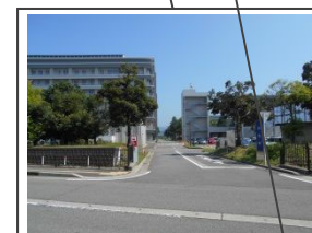
■附属病院救急部出入口
