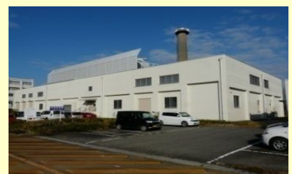
⑤. 中央機械室(エネルギーセンター)(1981) 築40年を経過し、老朽化が進んでいる。病院、校舎等ほとんどすべての熱源、電源、水道の供給をしている。ボイラー、冷凍機、中央監視、自家発電設備等を一部改修済。 また、2014年度に管理一体型ESCO事業に関連し、熱源設備・システムの大型改修を行った。
