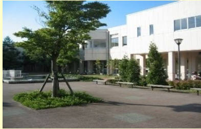
①. 基礎実習棟(1980) 松岡キャンパスで最初に建てられた建物。耐震性に問題はないが、築41年を経過し、老朽化が進む。
