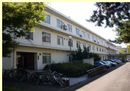
④. 総合研究棟Ⅶ-2(工学系4号館(東)) (1985) 耐震性は確保されているが、築36年で老朽化・機能劣化が進んでおり、工学系建物の中で唯一未改修である。
