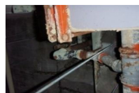
腐食・発錆が著しい配管類
