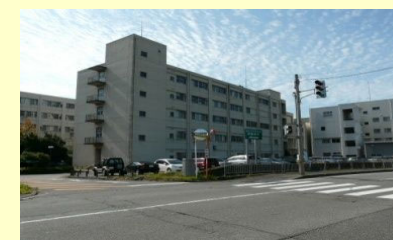
⑩. 院生研究棟(1985) 築36年を経過し、老朽化・機能劣化が進んでいる。
