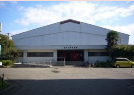
①. 第1体育館(1965) 築56年を経過し老朽化が著しい。また、随時部分改修を行っているが、天井高が低く、公式試合が出来ない等、活動に支障をきたしている。
