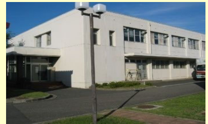
⑧. 福利施設(1983) 築38年を経過し、老朽化が進んでいる。
