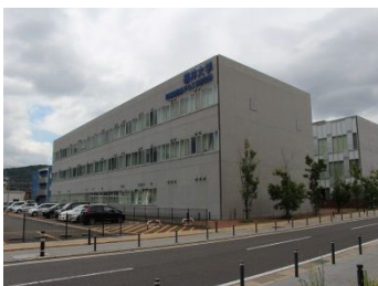
④. 北西面外観
