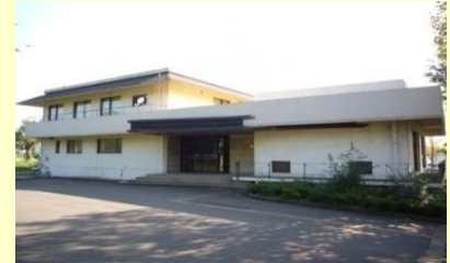
⑪. くずりゅう会館(1986) 築35年を経過し、老朽化が進んでいる。非常勤講師宿泊施設、職員福利施設。
