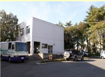
③. 保健管理センター(1975) 築46年を経過し、老朽化が進んでいる。
