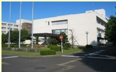
④. 管理棟(1981) 耐震性は確保されているが、築40年を経過し、老朽化が進んでいる。また、バリアフリー対応になっていない。
