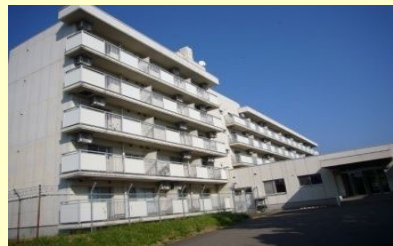
⑦. 看護師宿舎(1983,1996) 築38年を経過し、老朽化が進んでいる。1996年に部分改修を行った。
