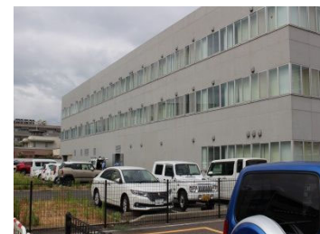
⑥. 南東面外観
