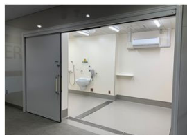
■A棟除染室改修 (除染室)
