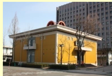
⑤. 総合情報基盤センター(1986) 築35年を経過し、老朽化が進んでいる。2011年に外壁・防水改修完了。
