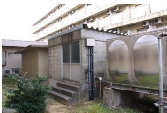
⑤. ポンプ室(1975.2000)
