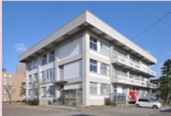
②. 本部棟(1967,1988, 2016耐震改修) 築54年を経過し、老朽化が進んでいる。2016年に耐震改修のみ完了したが、機能が悪い。また、来客が多く、スロープや自動扉の設置等出入口のバリアフリーを行ったが、内部はバリアフリーに対応していない。
