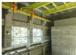
■大型構造物実験室(上部)
