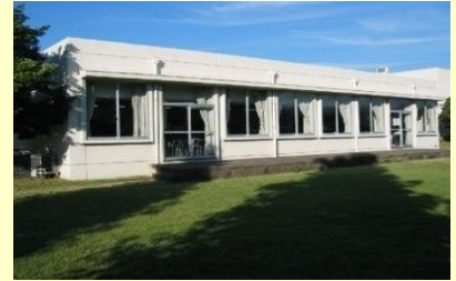
②. 食堂(1980) 築41年を経過し、老朽化が進んでいたため、平成22年度に一部内部のリフレッシュ改修を行った。また平成27年度に厨房の改修を行った。
