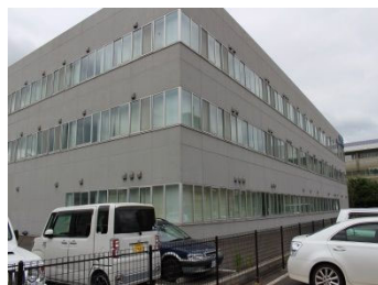
⑤. 東面外観
