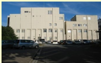
⑥. RI施設 (1982, 1994) 築39年を経過し、施設・設備等の老朽化が著しい。生物資源部門は2021年度に改修を完了しており、引き続きRI部門のアイントープ施設の更新が必要である。
