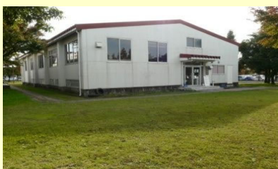
⑨. 武道場(1984) 築37年を経過し、老朽化が進んでいる。2011年に便所等のアメニティスペースの改修を行った。
