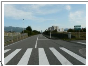
■みなし公道(北側)出入口 一般車両の通行(通り抜け)も多い。
