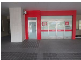
■A棟除染室改修 (外観)
