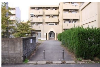
④. 留学生会館A棟・B棟(1988)
