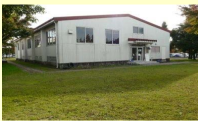
⑨. 武道場(1984) 築34年を経過し、老朽化が進んでいる。2011年に便所等のアメニティスペースの改修を行った。
