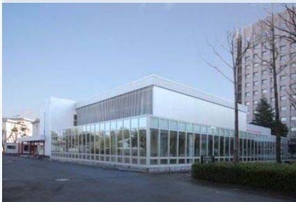
⑪. 学生支援センター(食堂)(1970, 2013増築) 2013年に生協の寄付等により食堂の増築を行った。
