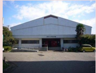
②. 第1体育館(1965) 築53年を経過し老朽化が著しい。また、随時部分改修を行っているが、天井高が低く、公式試合が出来ない等、活動に支障をきたしている。
