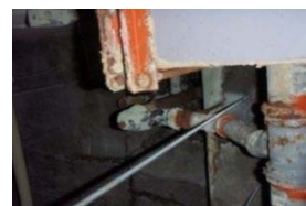
腐食・発錆が著しい配管類
