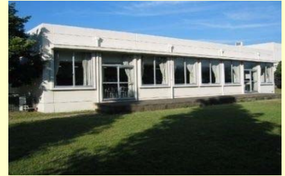
②. 食堂(1980) 築38年を経過し、老朽化が進んでいたため、平成22年度に一部内部のリフレッシュ改修を行った。また平成27年度に厨房の改修を行った。
