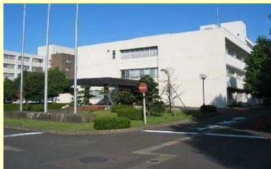
④. 管理棟(1981) 耐震性は確保されているが、築37年を経過し、老朽化が進んでいる。また、バリアフリー対応になっていない。
