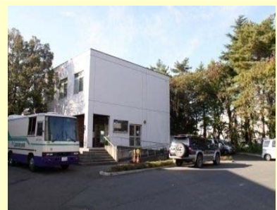
⑦. 保健管理センター(1975) 築43年を経過し、老朽化が進んでいる。
