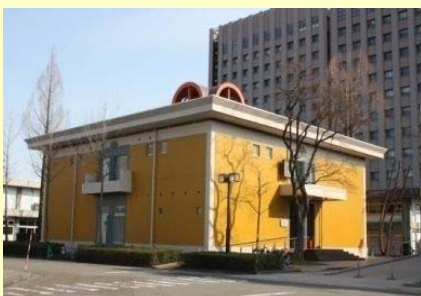
⑧. 総合情報基盤センター(1986) 築32年を経過し、老朽化が進んでいる。2011年に外壁・防水改修完了。
