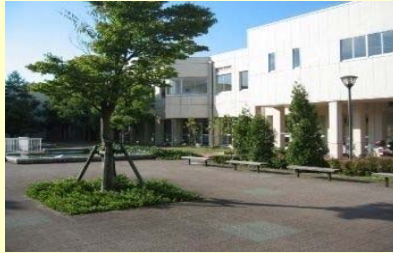
①. 基礎実習棟(1980) 松岡キャンパスで最初に建てられた建物。耐震性に問題はないが、築38年を経過し、老朽化が進む。
