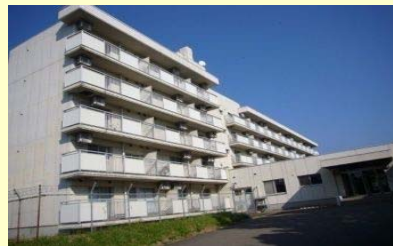
⑦. 看護師宿舎(1983, 1996) 築35年を経過し、老朽化が進んでいる。1996年に部分改修を行った。
