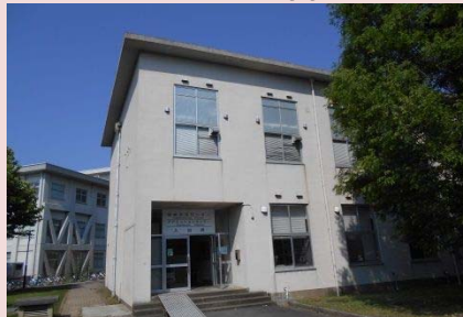
④. アドミッションセンター・留学生センター(1960) 築58年を経過し、老朽化が進んでいる。また、耐震性も劣ることから他の施設と統合・集約した改築整備が必要である。 (2020～2021①⑤と一体で整備中)
