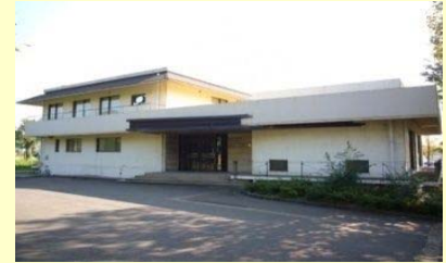
⑪. くずりゅう会館(1986) 築32年を経過し、老朽化が進んでいる。非常勤講師宿泊施設、職員福利施設。
