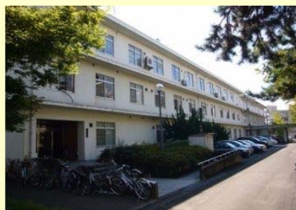
⑥. 総合研究棟Ⅶ-2(工学系4号館(東))(1985) 耐震性は確保されているが、築47年及び33年で老朽化・機能劣化が進んでおり、工学系建物の中で唯一未改修である。
