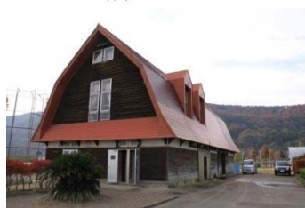
②. 管理作業棟(1986)
