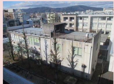
⑤. 留学生センター分室(1953, 1959) 築65年を経過し、老朽化が著しいことから他の施設と統合・集約した改築整備が必要である。 (2020～2021①④と一体で整備中)
