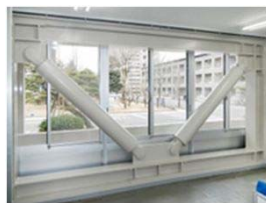
■1階_広報センター
