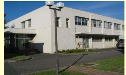
⑧. 福利施設(1983) 築35年を経過し、老朽化が進んでいる。
