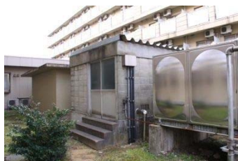
⑤. ポンプ室(1975.2000)
