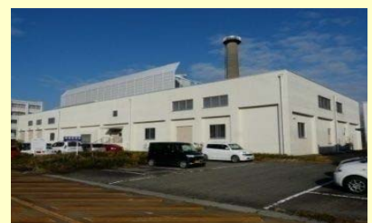
⑤. 中央機械室(エネルギーセンター)(1981) 築37年を経過し、老朽化が進んでいる。病院、校舎等ほとんどすべての熱源、電源、水道の供給をしている。ボイラー、冷凍機、中央監視、自家発電設備等を一部改修済。 また、2014年度に管理一体型ESCO事業に関連し、熱源設備・システムの大型改修を行った。
