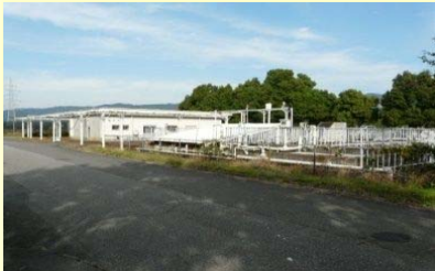
③. 排水処理機械室(1980) 築38年を経過し、老朽化が進む。
