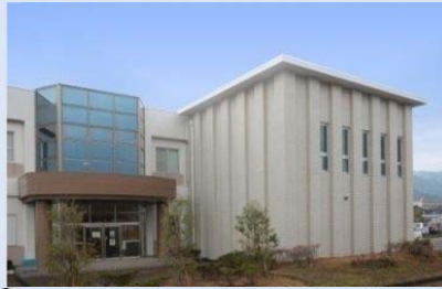
⑫. 高エネルギー医学研究センター(2000,2011) 本学が重点研究とし、COEを獲得している生体画像医学の研究拠点となっている。2011年に寄付金により増築を行った。
