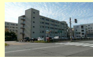
⑩. 院生研究棟(1985) 築33年を経過し、老朽化・機能劣化が進んでいる。
