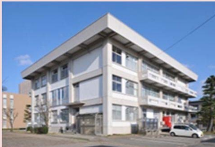
③. 本部棟(1967,1988, 2016耐震改修) 築51年を経過し、老朽化が進んでいる。2016年に耐震改修のみ完了したが、機能性が悪い。また、来客が多く、スロープや自動扉の設置等出入口のバリアフリー化を行ったが、内部はバリアフリーに対応していない。
