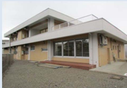
⑫. 牧島ハウス(留学生宿舎) (1983, 2018改修) 2018年に「県内大学等留学生宿舎整備事業補助金」等により留学生宿舎への改修を行った。
