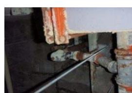
腐食・発錆が著しい配管類
