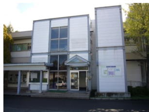
学生支援センター：学生数の増加に比べ面積はほとんど増加していないため狭隘である。
