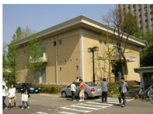
総合情報基盤センター：築 20 年を超えているが文京では比較的新しい建物。
