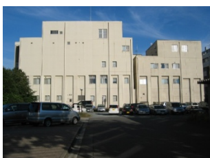
生物資源棟(動物実験施設): 耐震性に問題はない。
