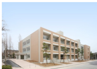
総合図書館：平成 20 年度耐震改修に伴い書庫を増築し、高機能化を図った。
