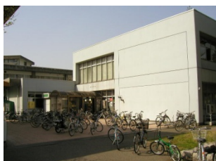
厚生会館・食堂：H18 年に生協の寄付でリフレッシュ工事が完了。明るくなり、学生・教職員の評判もよい。
