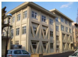
教育地域科学部 2 号館: H20 年、共用講義棟として耐震・機能改修済。耐震性の著しく劣る部分は総合研究棟 I 増築として改築。
