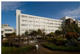
基礎研究棟: 基礎医学研究の中心となっている。平成20年、耐震改修工事が行われた。
