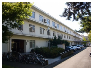
工学部 4 号館: 耐震性は確保されているが、一部経年による老朽化が進んでいる。
