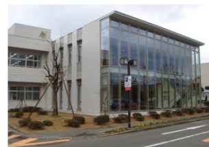
松岡図書館：整備率が低く狭隘であったが、平成21年度に増築・改修を行った。
