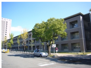
工学部 1 号館 1 号棟: H18 年までに耐震・機能改修完了。メイン道路に面するため意匠を考慮しダブルスキン法を採用。前面の環境整備を行い正門付近が明るくなり雰囲気よかった
