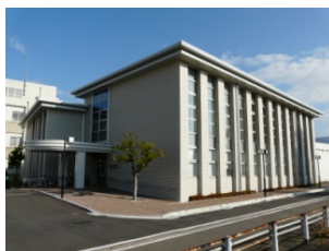
臨床教育研修センター：平成20年度完成
