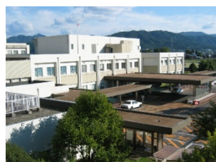
附属病院外来：附属病院外来玄関。駐車場がやや遠い位置にあり、連絡する通路に屋根がないため不便であったが、平成20年度正面玄関前外来駐車場69台増設により一部解消された。
