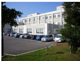
リハビリ棟：既存施設が狭隘であるため平成 17 年に自己資金にて増築整備を行った。
