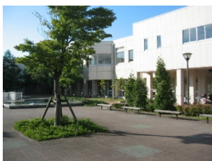
講義棟・実習棟: 松岡キャンパスで最初に建てられた建物。耐震性に問題はないが、老朽化が進む。
