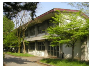
実験棟: 築 43 年を経過し、老朽化が進み、耐震性も悪いので改修を計画する。
