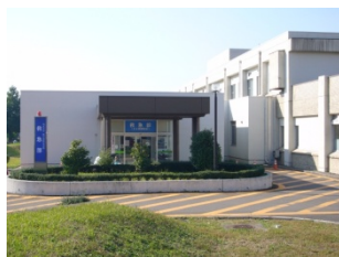
救急部棟：病院玄関の反対側ではあるが、救急車が進入しやすい幹線道路に近い位置にある。
