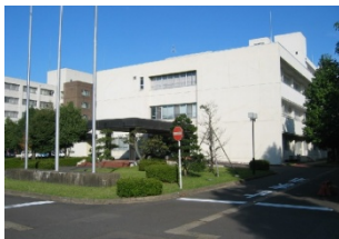
管理棟：耐震性に問題はない。
