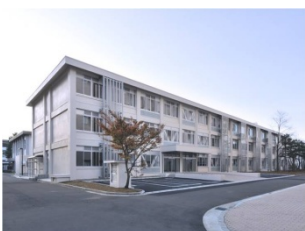
工学部 2 号館: 築 42 年を経過し、老朽化が著しかったが、耐震・機能改修完了。
