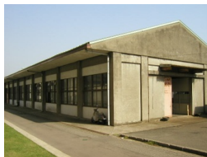
先端科学技術育成センター(旧機械工場): H19 年に耐震改修完了。
