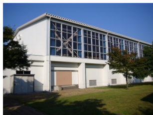
体育館：平成19年に耐震改修工事を完了している。
