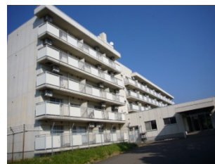
看護師宿舎：附属病院看護師のための宿舎。平成 8 年に内部改修（単身室増設）を行って生活環境の改善を実施済み。
