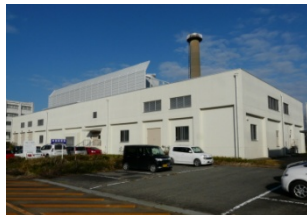
中央機械室(エネルギーセンター)：病院、校舎棟ほとんどすべての熱源、電源、水道の供給をしている。ボイラー、冷凍機、防災監視、昇降機、自家発電設備等を一部改修済
