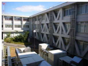
工学部 1 号館 2 号棟: H14 年に耐震・機能改修完了。外付けフレーム工法を採用。
