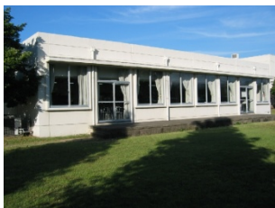
食堂：耐震性に問題はないが、築27年で老朽化も進んでいる。内部のリフレッシュ改修も必要である。
