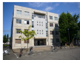
課外活動共用棟: 本学では比較的新しい施設。今後とも適切な維持保全を行い有効に活用する。
