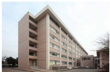
教育地域科学部 1 号館: 築 40 年を経過し老朽化が著しかったが、H20 年開設の教職大学院の拠点でもあり、学部での有効活用を考慮した耐震・機能改修工事を H20 年～H21 年に行った。
