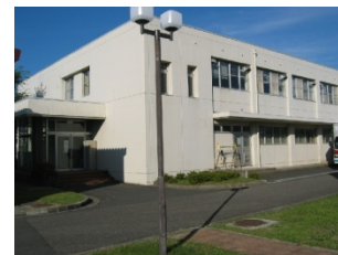
福利施設：デュアル教育の導入で、一部がデュアル室として使用されている。その分学生の共通部分が少なくなっている。
