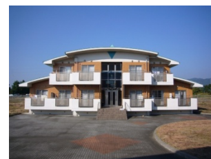
国際交流会館：留学生やその家族が入居している。デザイン的にも工夫された建物となっている。
