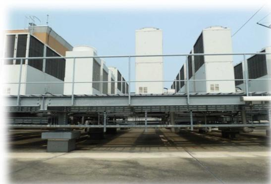
写真 13 機器エリア（上）と配管等エリア（下）をデッキで分けたメンテナンススペースの例
