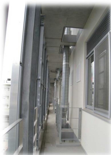
写真 12 配管等の更新・増設のためのスペースを確保したメンテナンスバルコニーの例
