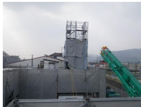
(厨房煙突解体)
