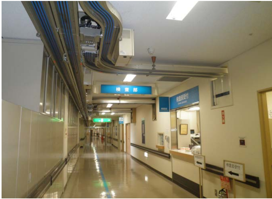
検体検査部門(改修前)
