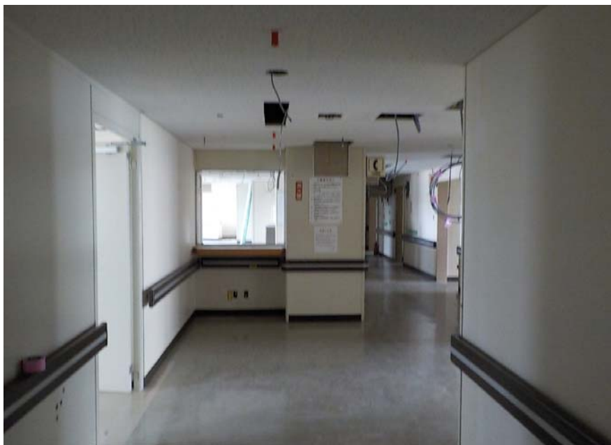
西病棟3階(改修前)
