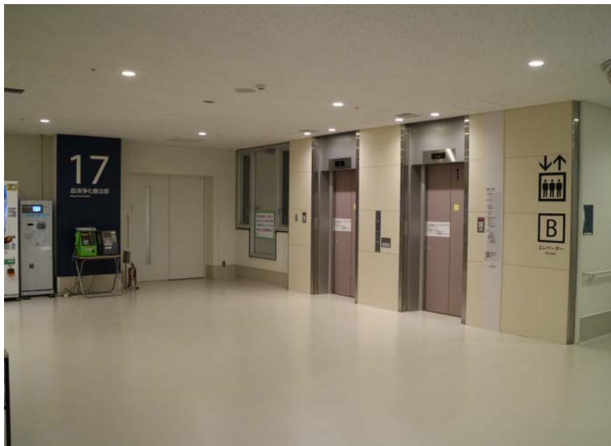
B棟1階EVホール(改修後)
