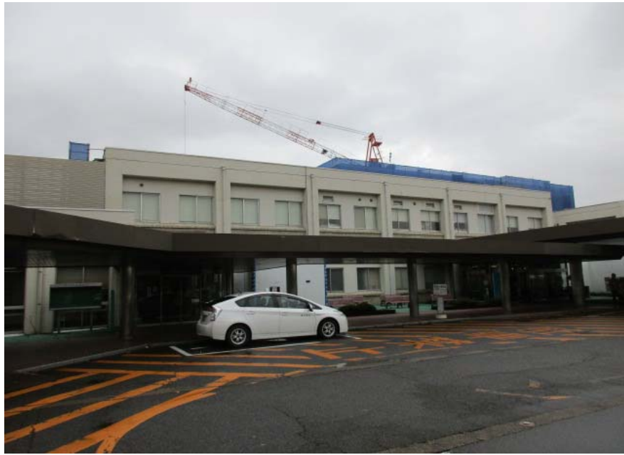
西面正面玄関(改修前)
