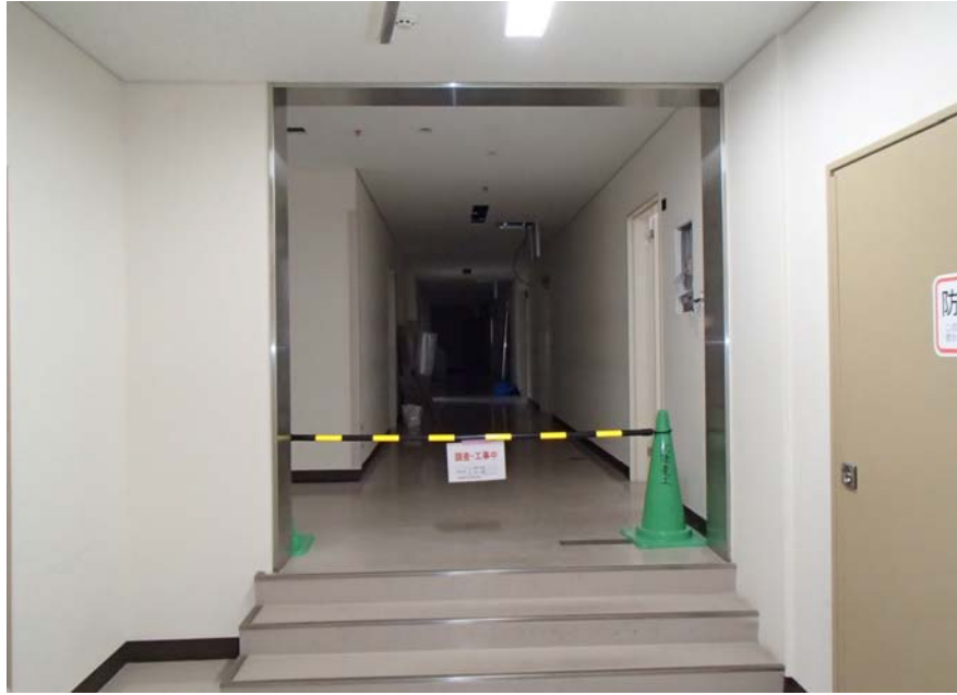
通院治療センター(改修前) (旧検査部諸室)
