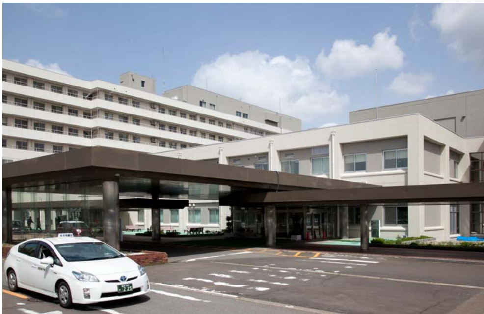
西面正面玄関(改修後)
