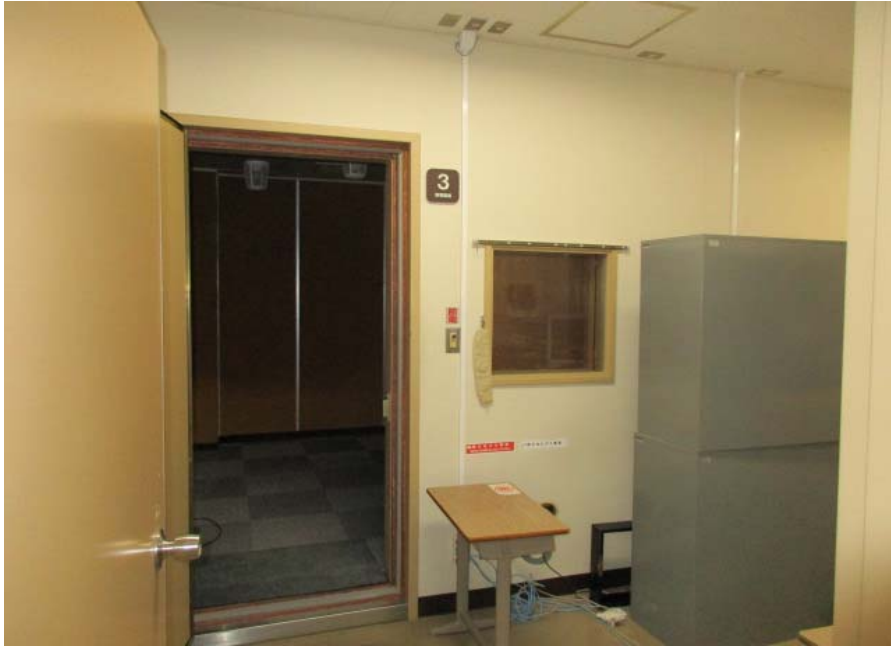
脳波検査室(改修前)
