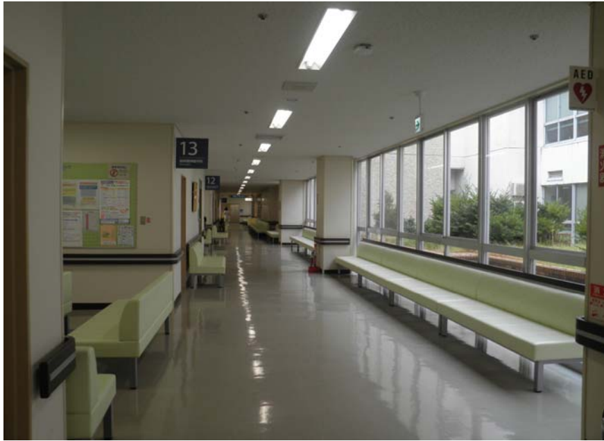
外科外来前廊下(改修前)
