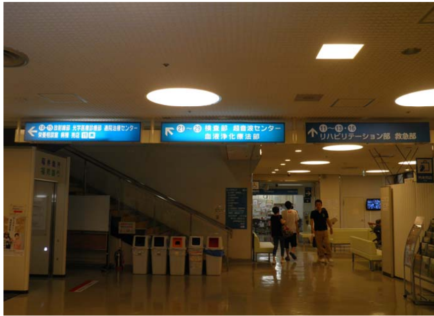
外来階段(改修前)
