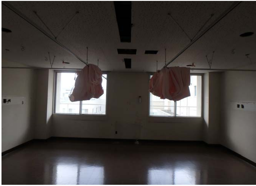
東病棟3階(改修前)
