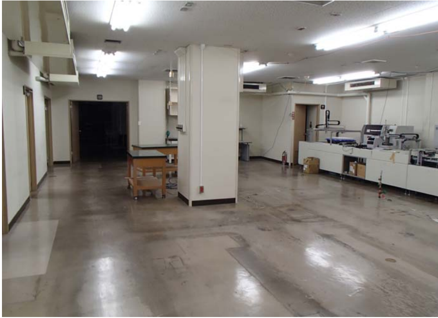
生理検査部門(改修前) (旧検体検査部門)
