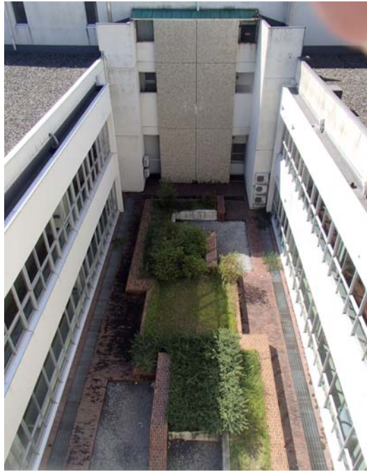
外来階段(改修前) (旧ライトコート)
