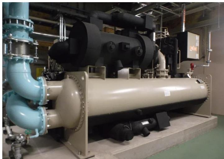
排熱回収ヒートポンプチャラー 給湯・暖房用 70冷凍トン 暖房用 130冷凍トン
