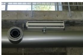
3階まで吹き抜けの大型構造物実験室には空調吹き出し上部に搬送ファンを設置して暖かい吹き出し空気を冷気で覆い、暖気の上昇を防ぎ空調効果を上げるようにしています。
