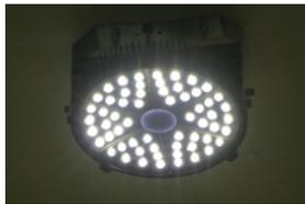
省エネ・環境対策にも配慮しています。共通部分・高天井部分の照明器具はLEDを採用しています。写真は水銀灯の代わりに採用したLED器具です。水銀灯に比べると半分以下の消費電力です。また、一度消灯してもすぐ点灯できる為、不要なときは積極的に消灯できるようにしています。
