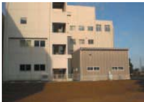
新しく完成したRI排水設備
