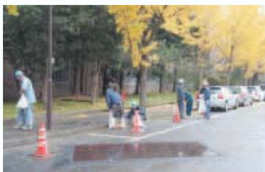
工事関係者による一斉清掃
