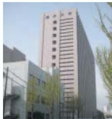
完成時全景（08年4月）
