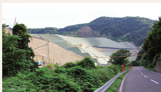
図1 国道476号線から撮影した敦賀市楳曲の最終処分場 現在、有害物質が漏れ出さないように周辺遮水壁や防水シート、覆土などの様々な処置が施されているが、有害物質の監視は継続されている。
