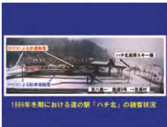
図-1 道の駅「はち北」の駐車場と歩道の融雪システム
