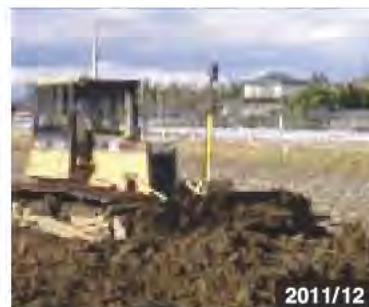
(c)重機による排土の様子
