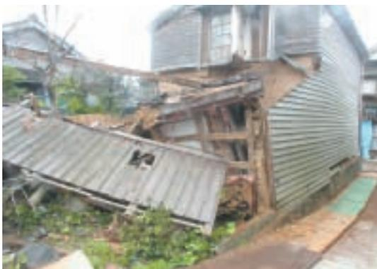
下屋部分の破壊(構造強度が不足している)
