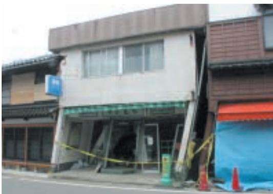
商店建築の被害(間口一杯が開口部のため強度が弱くなっている)
