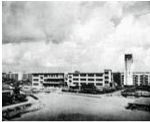
この「西戸山小学校（昭和25年，東京都新宿区）」は，鉄筋コンクリート造のモデルスクールとして建てられました。以降は災害に強く，丈夫で室内環境にも秀でたRC造の校舎が全国に普及していきました。
