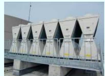
更新された空調屋外機
